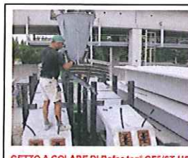
GETTO A COLARE DI REFOR-tec® GF5/ST-HS
